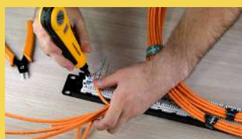
5. Забиваем проводники,
