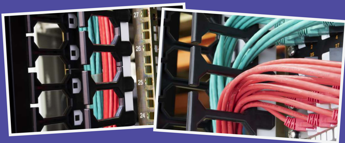
Разведение кабеля внутри органайзера
