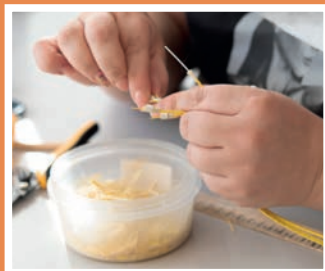
Зачистка отрезка кабеля и сборка патч-корда
