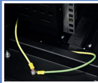
Заземление в шкафу TFR-R
