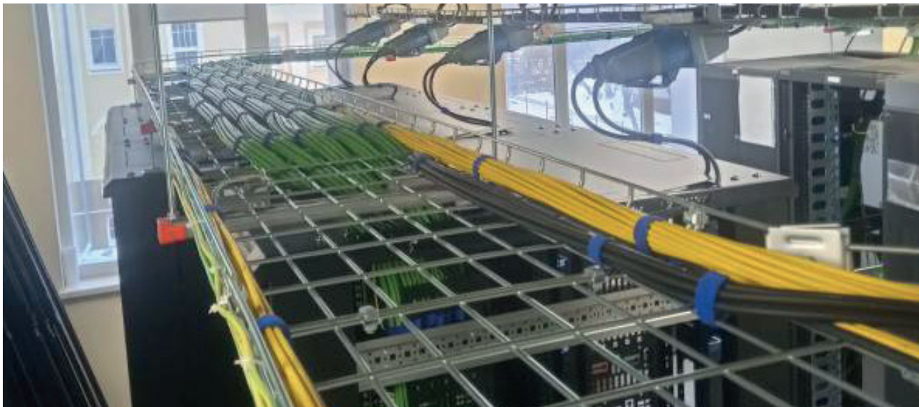
Раскладка кабеля в серверной Сбербанка
