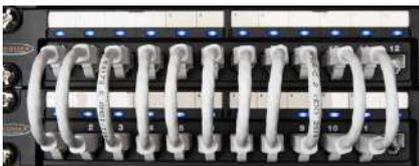
Коммутация подсистем по модели кросс-соединения
