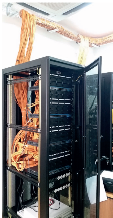
Процесс монтажа в шкафу TFE-426010-GPPP-BK
