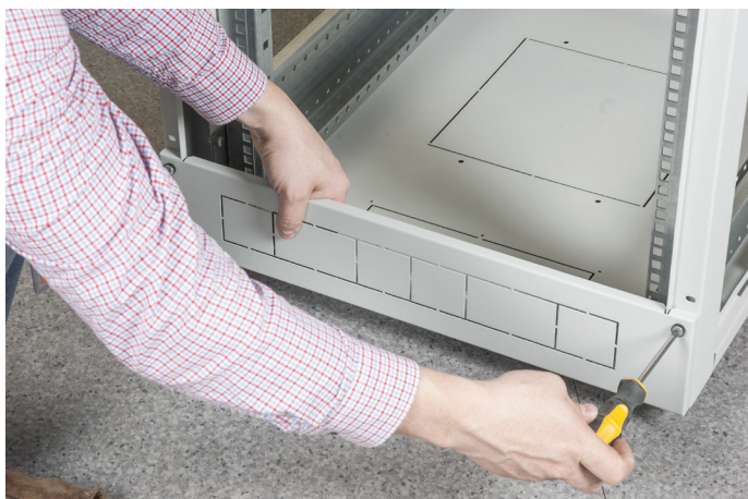
Монтируем панель кабельных вводов
