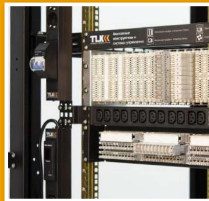
Одновременная установка вертикальных и горизонтальных блоков
