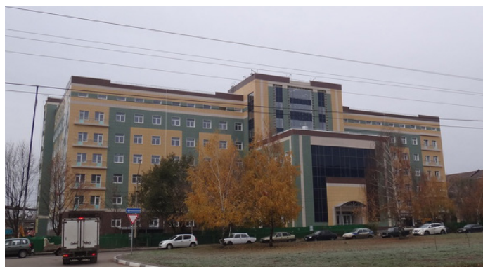
Перинатальный центр им. Преподобной Марфы Тамбовской г. Тамбов
