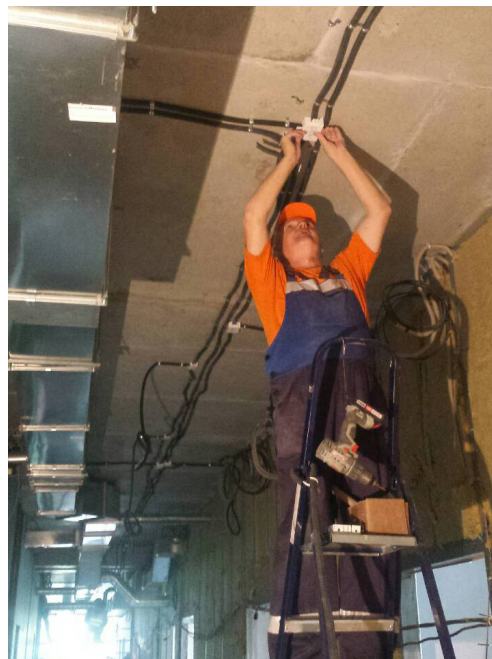
Монтаж распределительной коробки сотрудником ООО «СМС Строй»
