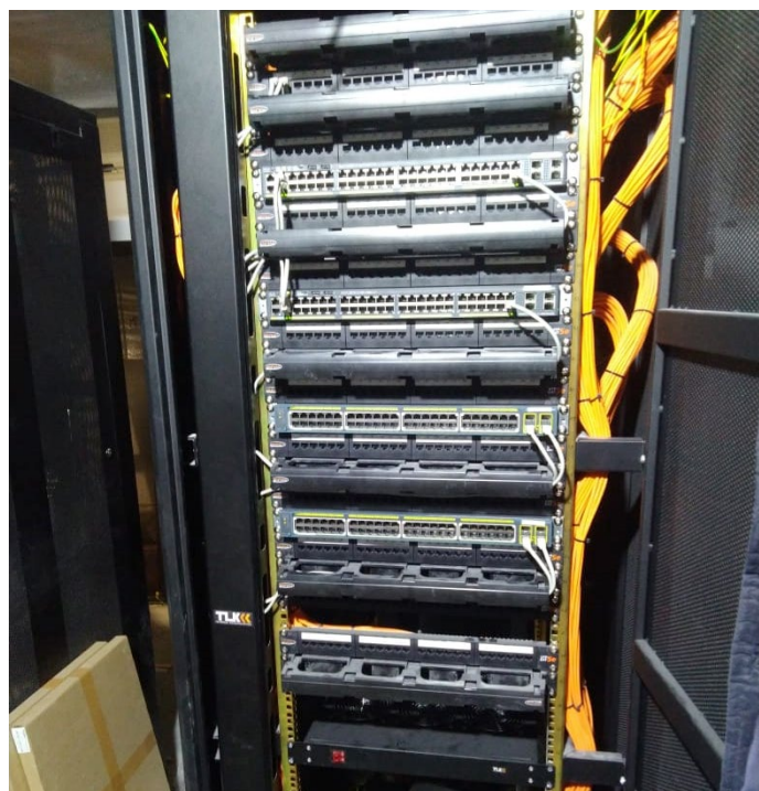
Монтаж в шкаф TLK
