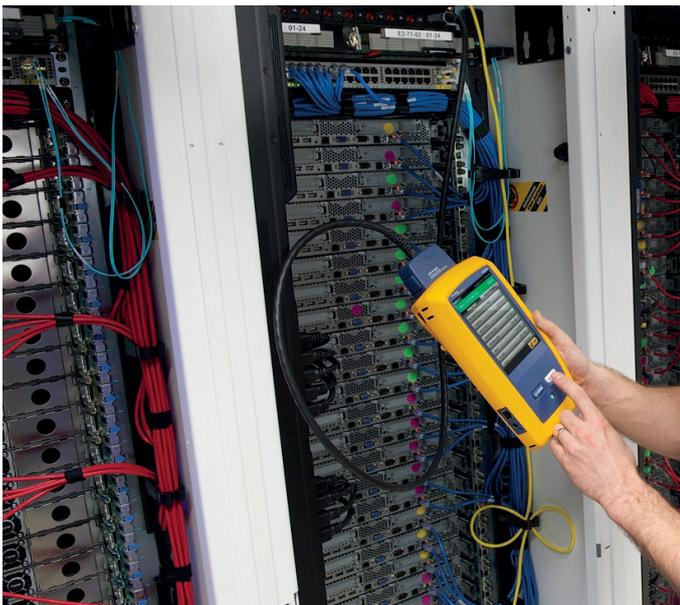
*Тестирование кабельной сети с помощью кабельного анализатора*
