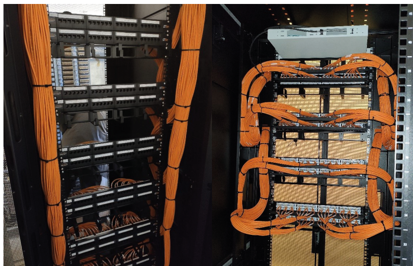
Смонтированный кабель NIKOMAX 4100C-OR
